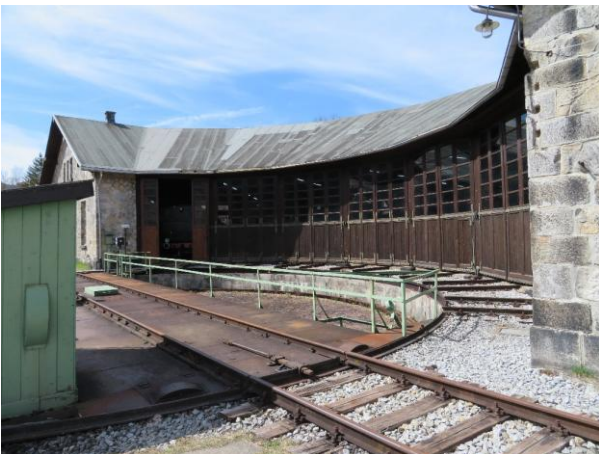
(3) Außenbereich des Museums mit Drehscheibe
