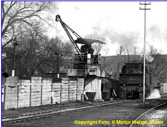
Kleinere Bekohlungsanlage mit Kran und Kohlbansen, Rottweil 04/1973
