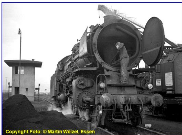
Löschke ziehen bei geöffneter Rauchkammertür. Ehrang 01/1972
