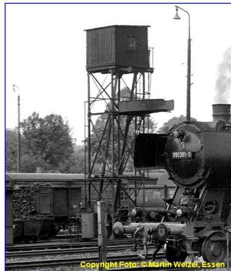
Kohlekran zur Beförderung der Kohle auf die hochliegende Rutsche. Marktrechwitz 07/1974
