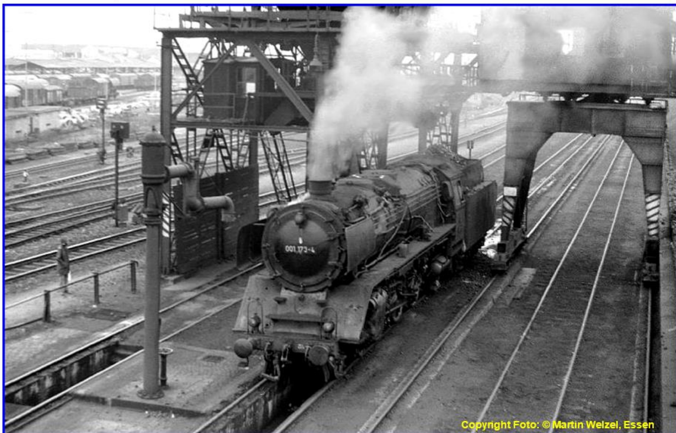
Lokbehandlungsanlage Hof, 5/1973 (vorne links Gruben, dazwischen Wasserkran, hinten Bekohlung)
