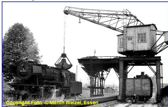
Kohlebunker mit Trichter und Portalkran. Crailsheim, 07/1974
