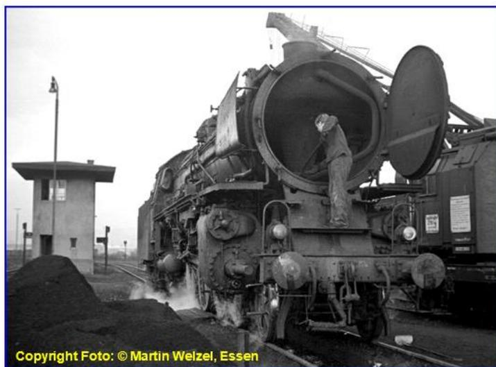
Lösche ziehen bei geöffneter Rauchkammertür. Ehrang 01/1972
