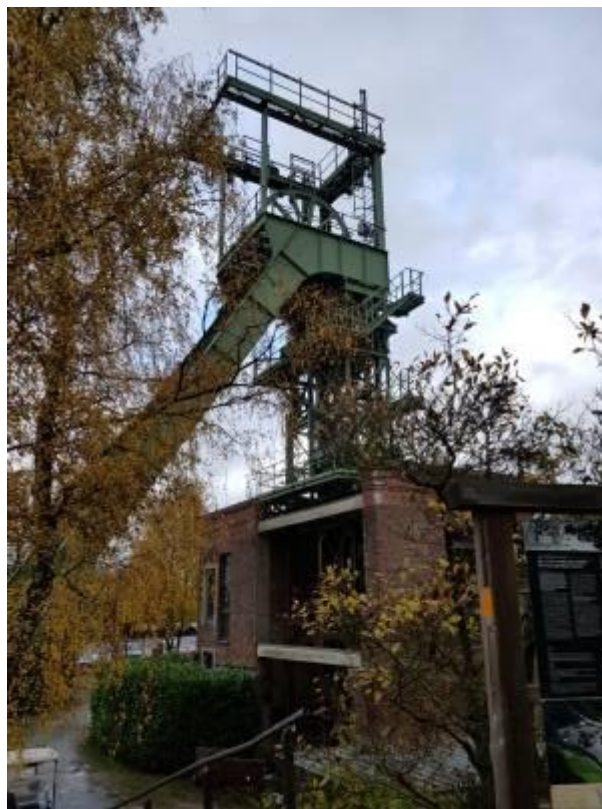
Förderturm und Betriebsgebäude
