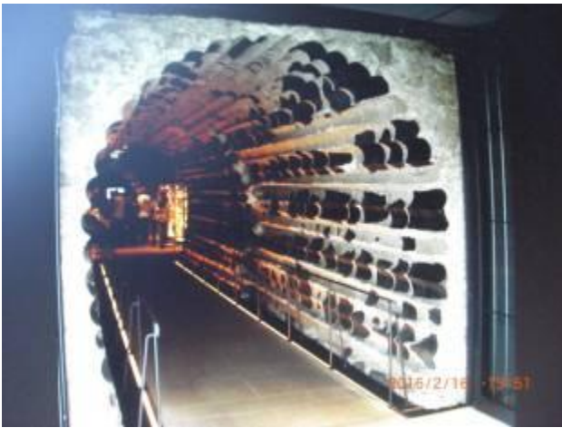
Neuer Zugang durch das Fundament
